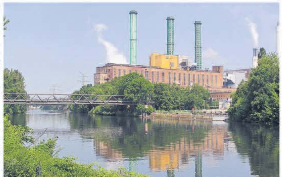
Die Schornsteine des Heizkraftwerks Reuter prägten jahrzehntlang das Stadtbild. Jetzt verschwinden sie Stück für Stück.
